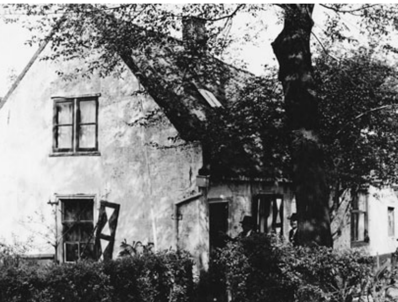
Het Koelewijnhuis uit 1740 van dichtbij.
