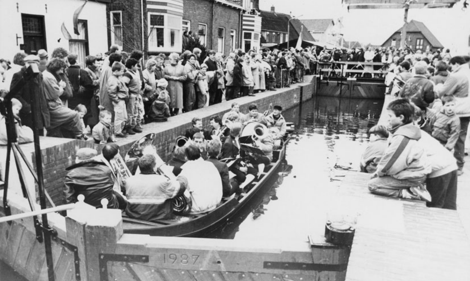
Grote belangstelling bij de opnieuw in gebruikstelling van de gerestaureerde Veense sluis in 1987
