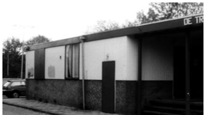
Het oude Treffersgebouw, gesloopt in 2000.
