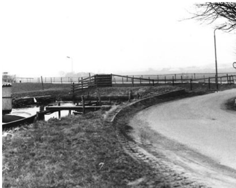
Het oude sluisgat uit 1816-1834 in de bocht van de Groenewoudsekade.
