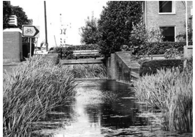
Een blik in de kolk van de gerestaureerde sluiswanden op het noordeinde van de Nieuwe Wetering.
